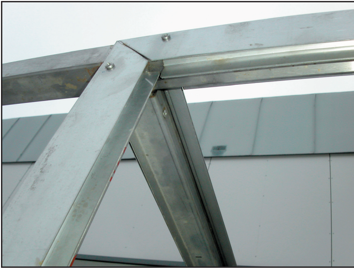
Svetsad rostfri stomme, fyrkantsrör 40x40 mm, med rostfria glasfästen. En atombombssäker och underhållsfri konstruktion.
